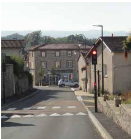
Le Conseil Municipal a décidé de mettre en place un projet afin de limiter la vitesse dans la traversée du bourg à la hauteur de l'école et de la salle la Civensoise. Un plateau traversant avec une limitation de vitesse à 30km/h et un feu tricolore devraient permettre de sécuriser la circulation piétonne.
